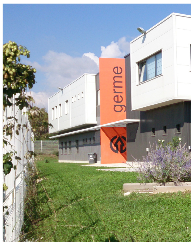
bâtiment GERME S.A.
